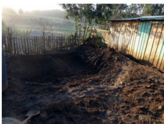
Figura 35. Excavación área de acumulación.
