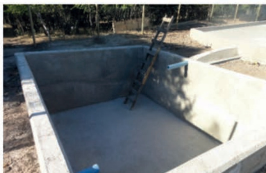
Figura 42. Hormigonado del área de acumulación.
