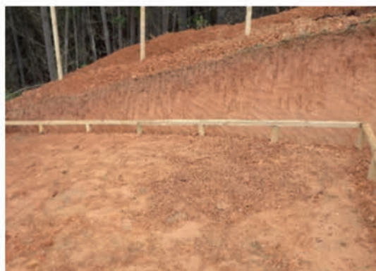
Figura 28. Área donde se emplazará el hidroacumulador de PVC
