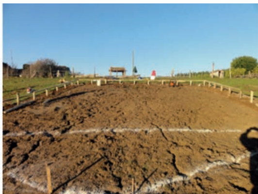
Figura 11. Estructura de soporte en polines impregnados enterrados.
