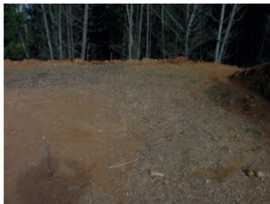
Figura 24. Limpieza del sitio demostrativo.
