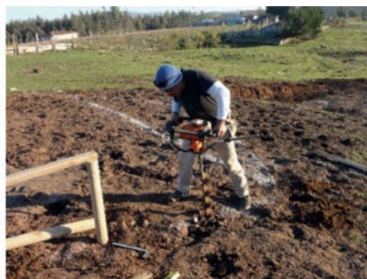
Figura 10. Trabajo de perforaciones con el barreno.
