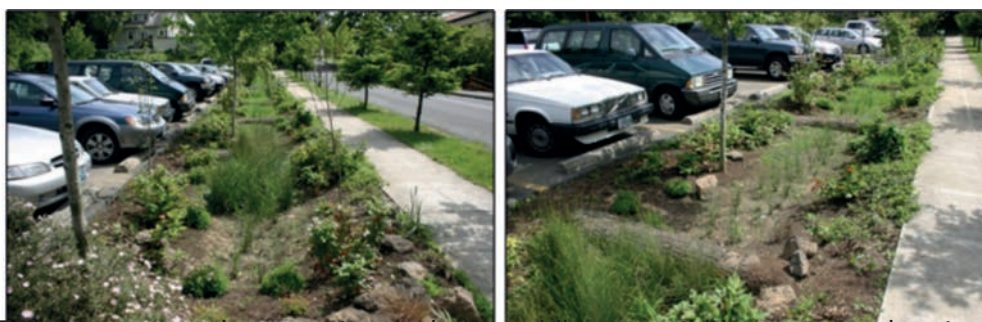
Figura 59b. Las nuevas leyes norteamericanas obligan a establecer zonas de retención de la escorrentía generada por los estacionamientos, las que se han aprovechado para establecer árboles, lo que reduce significativamente la temperatura mediante el efecto isla. Imágenes cortesía de Brad Lancaster, www.HarvestingRainwater.com .
