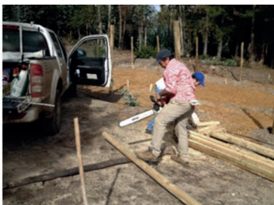
Figura 9. Trabajo de carpintería, corte de los polines
