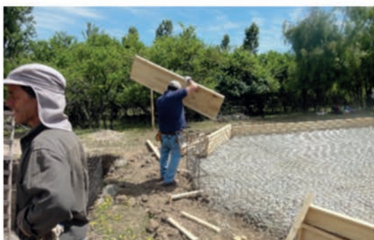
Figura 41. Instalación de moldajes.
