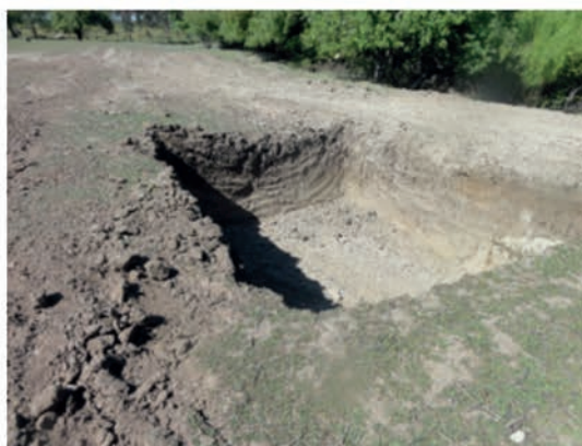
Figura 38. Movimiento de tierra y excavación de la zona de acumulación.
