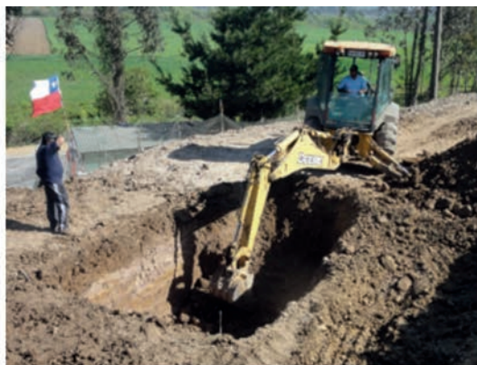
Figura 20. Trabajos de maquinaria para el movimiento de tierra.
