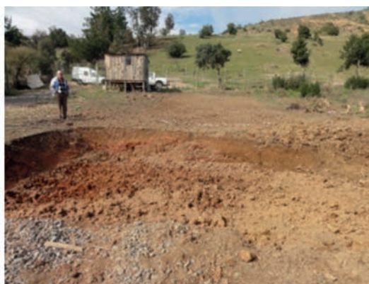
Figura 6. Limpieza y escarpado.
