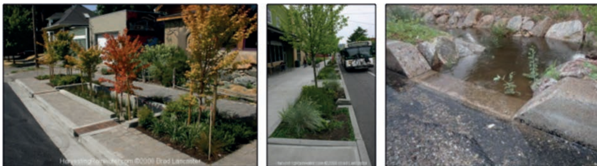
Figura 56. La escorrentía que fluye por las calles durante las tormentas se desvía hacia las zonas de acumulación mediante el corte de la berma. Imágenes cortesía de Brad Lancaster, www.HarvestingRainwater.com y Watershed Management Group, www.watershedmg.org .
