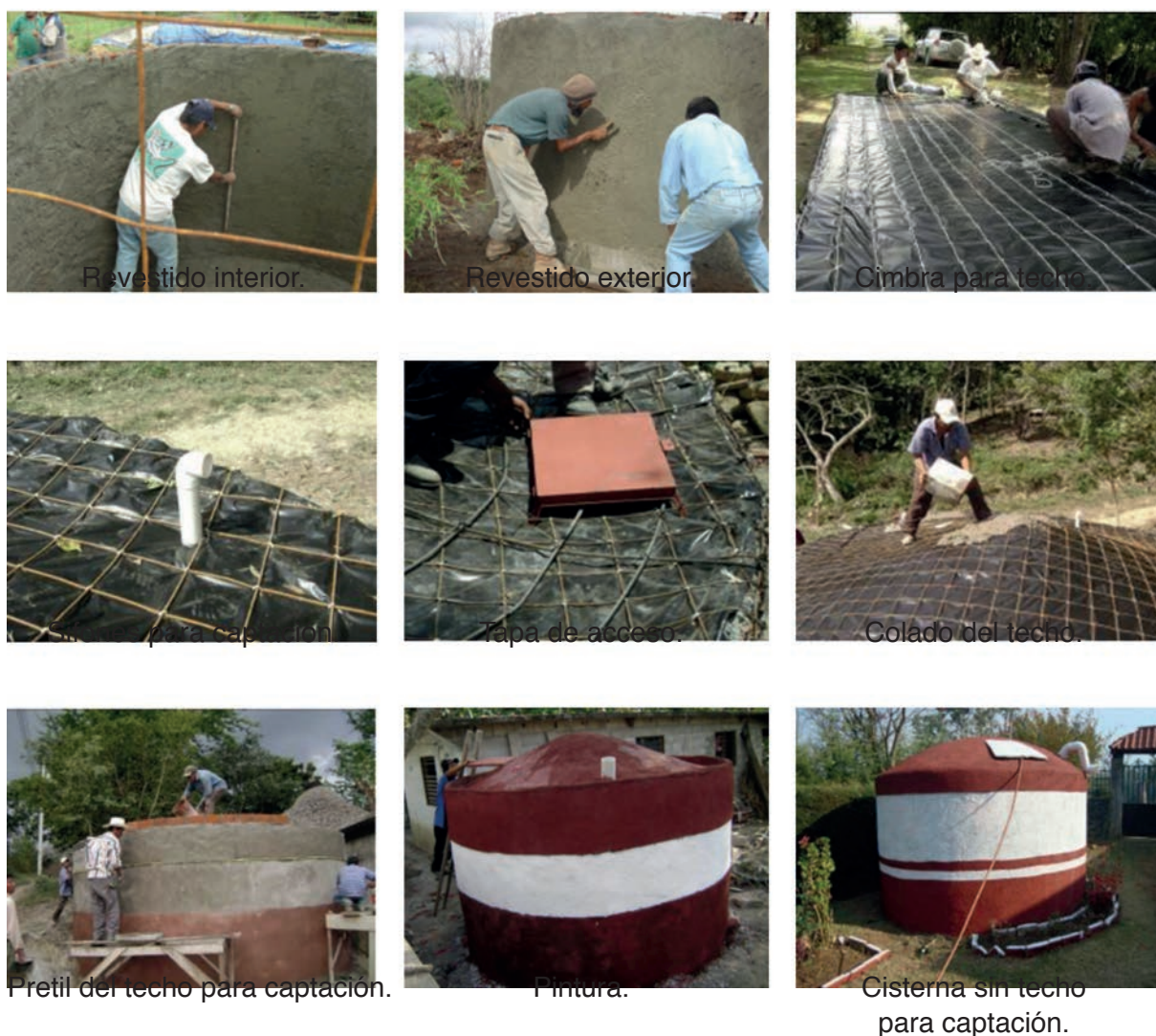
Figura 64. Proceso constructivo de cisterna tipo capuchina de 11 m 3 .
