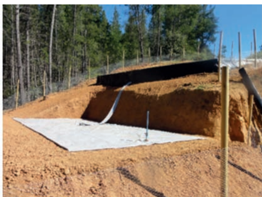
Figura 29. Instalación del hidroacumulador de PVC.
