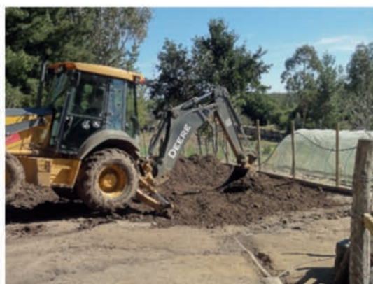
Figura 26. Movimiento de tierra con retroexcavadora.
