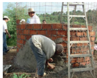
Colocación de muro con el tabique de canto (capuchino).
