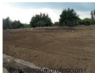
Retiro de capa vegetal y nivelación del terreno
