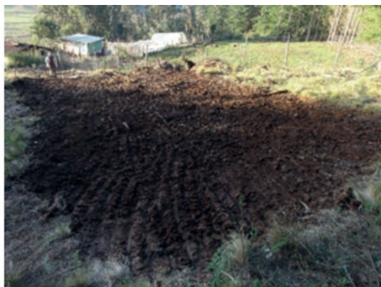
Figura 33. Movimiento de tierra.
