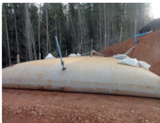
Figura 30. Hidroacumulador con agua.
