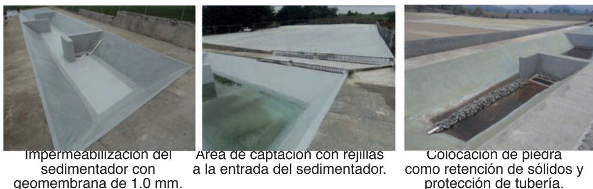
Figura 63. Construcción del área de captación en terreno natural.
