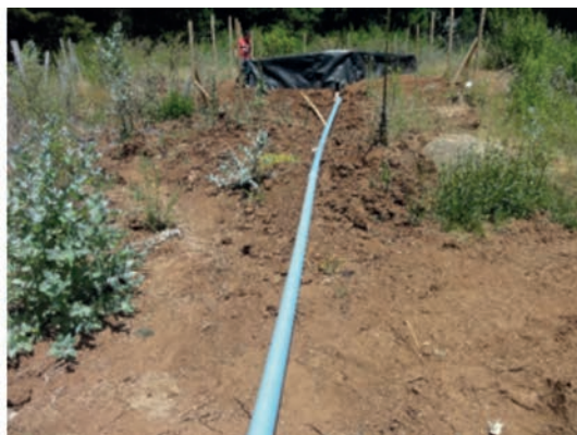
Figura 43. Instalación del sistema.
