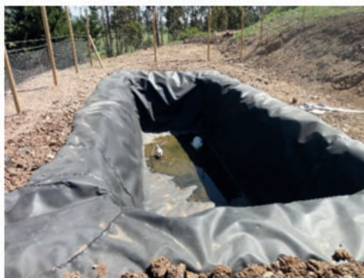
Figura 22. Área de acumulación con cubierta en Geomembrana HD de 1 mm de espesor.
