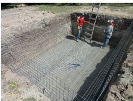
Figura 39. Enfierradura con malla Acma C- 139.
