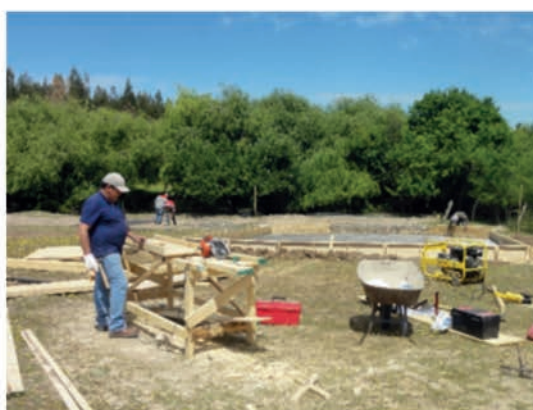
Figura 40. Trabajos de carpintería de moldaje para recibir el hormigón.
