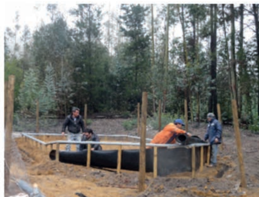
Figura 16. Sellado y soldado de la geomembrana.
