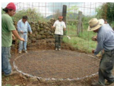
Preparación de terreno y armado de estructura.
