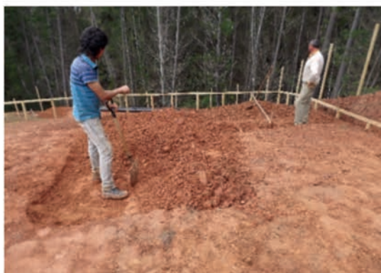
Figura 27. Excavación con herramienta de mano.
