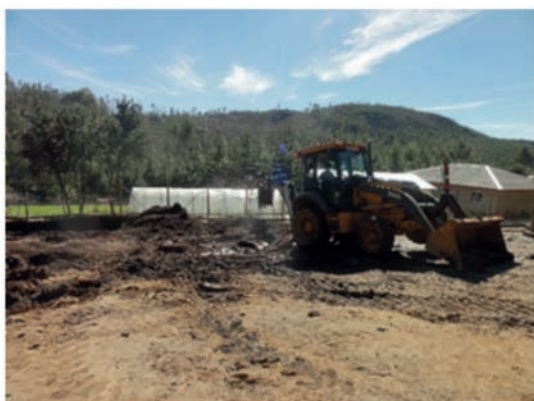
Figura 7. Movimiento de tierra con retroexcavadora
