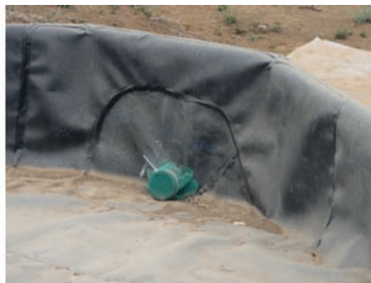
Figura 44. Rejilla plástica como filtro sencillo. de conducción.
