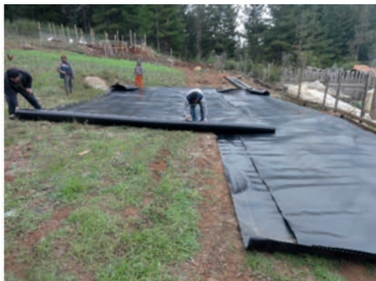
Figura 13. Corte de la geomembrana para su fusionado,
