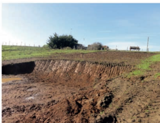
Figura 8. Movimiento de tierra con retro y pala.
