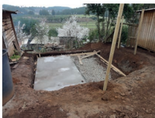
Figura 36. Radier en donde se emplazará el estanque de polietileno.
