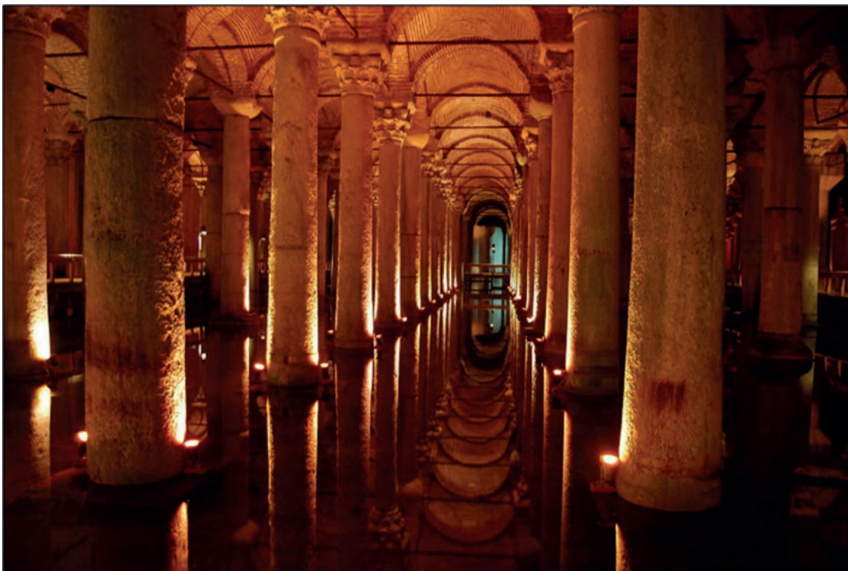
Figura 1. El Yerebatan Sarayi en Turquía, es considerado la cisterna de almacenamiento de aguas lluvia más grande del planeta, con una capacidad de 80 mil metros cúbicos. Imagen cortesía de Ron Kaczor.
