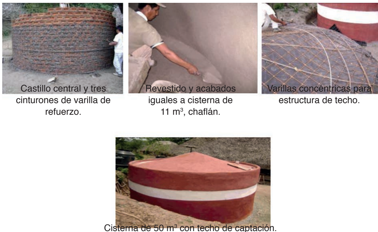
Figura 66. Proceso constructivo de cisterna tipo capuchino de 50 m 3 .
