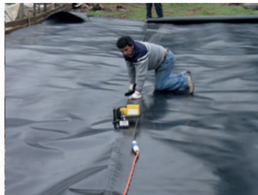
Figura 14. Fusionado de la Geomembrana.
