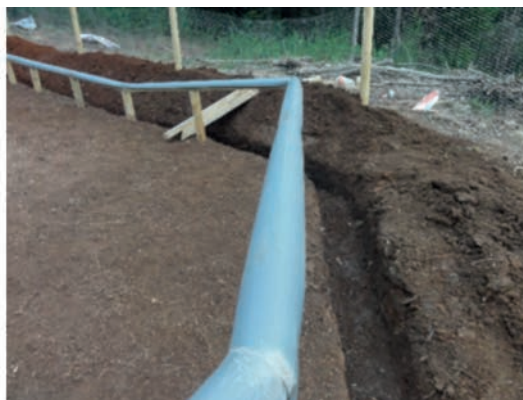
Figura 12. Coronación de los listones con PVC y Zanja.
