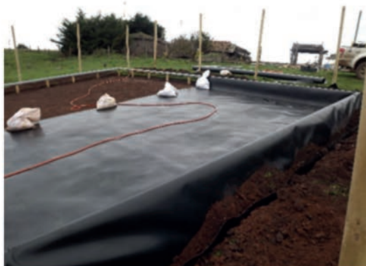
Figura 17. Zanja perimetral en donde va enterrada la geomembrana.
