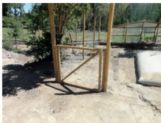
Figura 46. Puerta de acceso.
