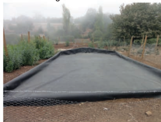
Figura 18. Área de captación terminada.
