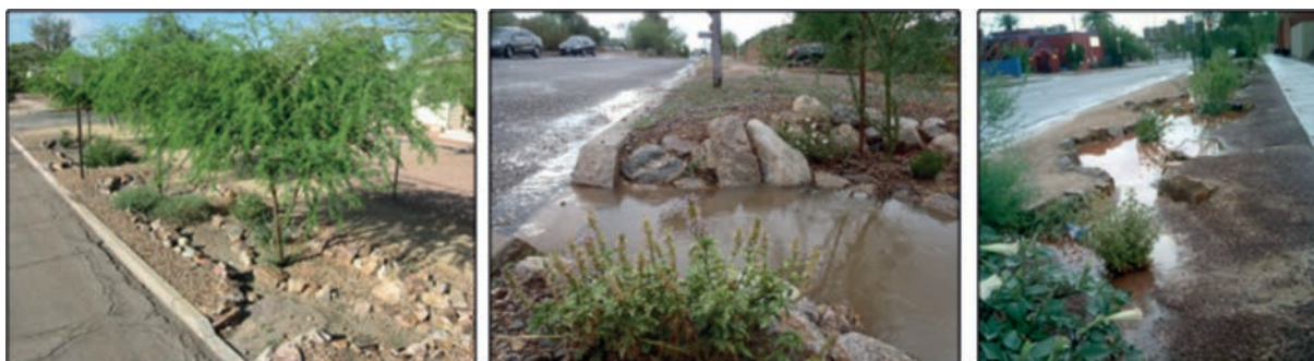
Figura 57. La infraestructura verde involucra la construcción de depresiones en la zona comprendida entre la calle y la propiedad privada, con el fin de dirigir el agua de lluvia que fluye por las calles. Imágenes cortesía de Watershed Management Group, www.watershedmg.org .
