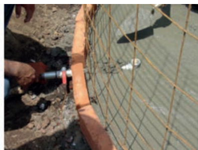
Colado del piso, instalación de válvula de salida.
