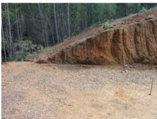
Figura 25. Parte del cerro que tiene que rebajarse para la zona de acumulación.
