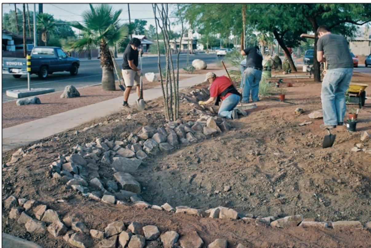
Figura 54. Construcción de una zona de almacenamiento, que evita que la escorrentía generada en la propiedad llegue a la calle. Imagen cortesía de Watershed Management Group, www.watershedmg.org .
